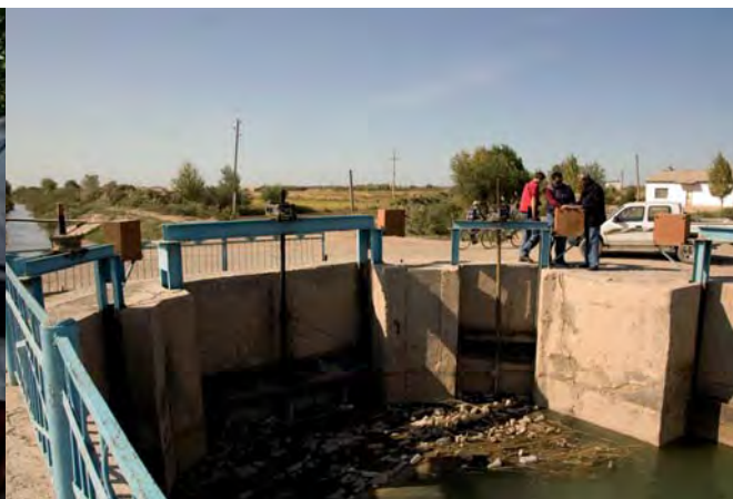
Ein Bewässerungskanal mit Verteilungsbauwerk
