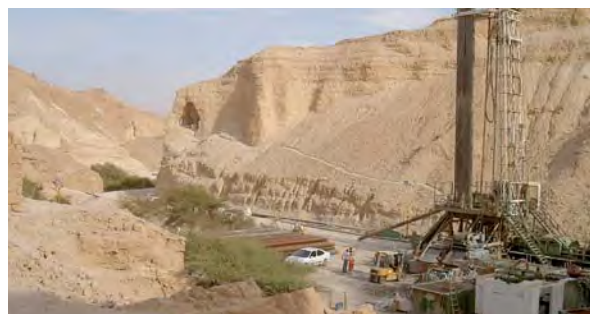
Probebohrung für einen Brunnen in der Judäischen Bergwüste nahe des Toten Meers im Rahmen eines Forschungsprojekts
