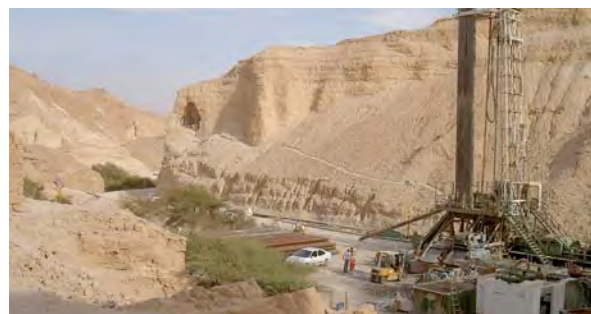
Probebohrung für einen Brunnen in der Jüdischen Bergwüste nahe des Toten Meers im Rahmen eines Forschungsprojekts
