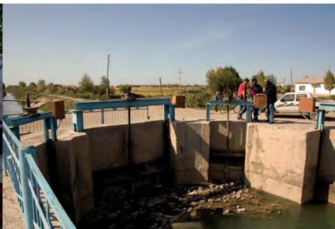
Ein Bewässerungskanal mit Verteilungsbauwerk
