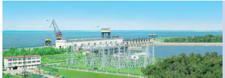
Wasserkraftwerk Nishegorodskaya bei Nishny Novgorod (Quelle: RusHydro)
