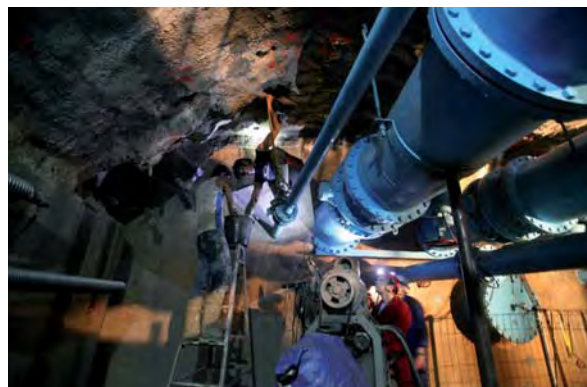
Bauarbeiten in der Höhle
