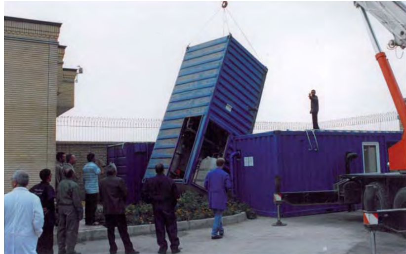
Aufstellung der Versuchsanlagen auf dem Gelände der Brunnenpumpstation in Mashhad
