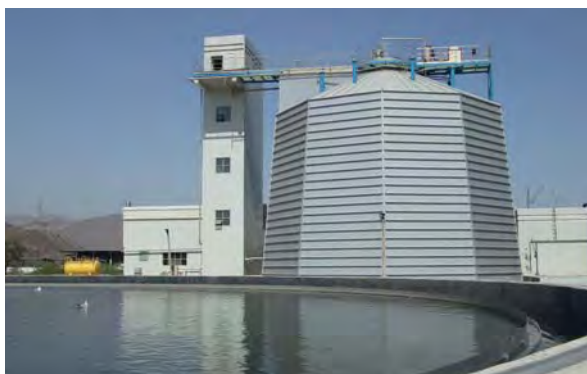
Nachklärung und Faulturm der Kläranlage Fujairah, Vereinte Arabische Emirate (zur Verfügung gestellt durch die Passavant-Roediger GmbH)
