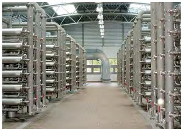
Ultrafiltrationsblock zur Spülwasseraufbereitung (2. Stufe)
