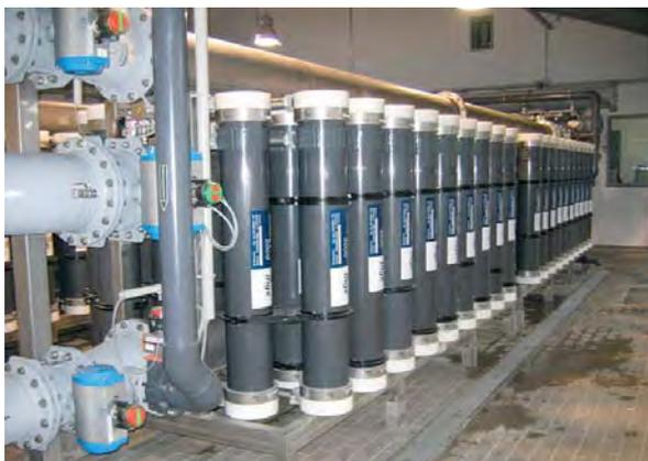
Ultrafiltrationsblöcke zur Trinkwasseraufbereitung (1. Stufe)
