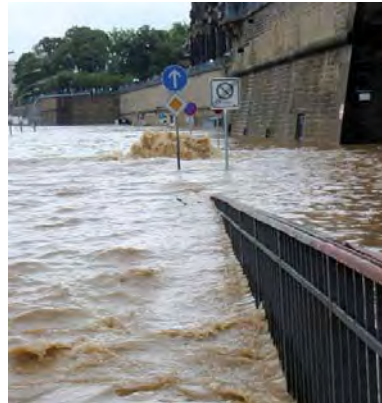
Hochwasser in Dresden: Wasseraustritt durch die Kanalisation am Terrassenufer
