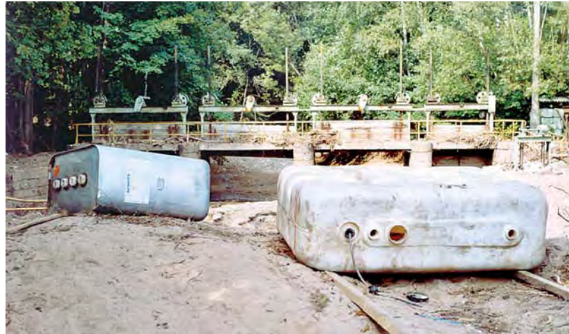
Durch die Elbeflut herausgerissener Öltank (Quelle: Thomas Egli)
