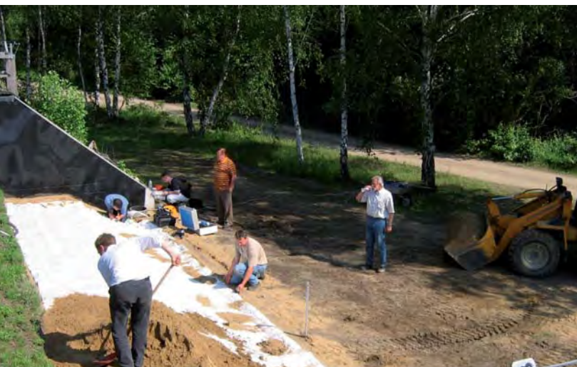
Feldversuch im 1:1 Labordeich des Franzius-Instituts für Wasserbau und Küsteningenieurwesen in Hannover
