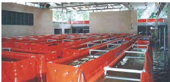
Bauwerkssicherung gegen aufsteigendes Grundwasser in einem Dresdner Gymnasium (Quelle: www.benno-gym.de )
