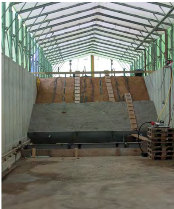
Am Modelldeich im natürlichen Maßstab (Höhe: 3 m) wird die technische Machbarkeit des Stabilisierungsverfahrens (Ansicht Landseite) nachgewiesen
